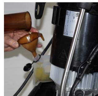
Depósito de óleo da bomba com visor de nível de óleo e função de enchimento/despejo.
